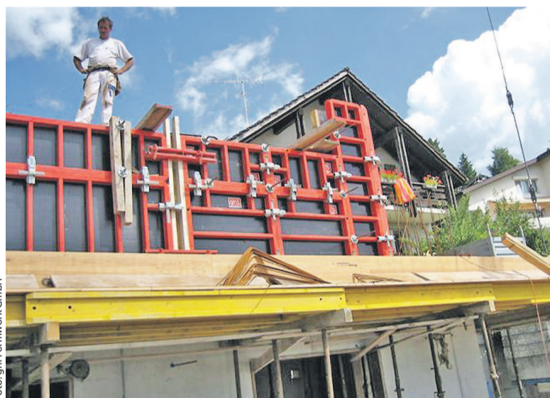
Abgetrepte oder schräge Aufstandsflächen, diverse Höhen, Wandversätze, Längen Anpassungen und Ecklösungen erlaubt das System TriTec ebenfalls problemlos.
