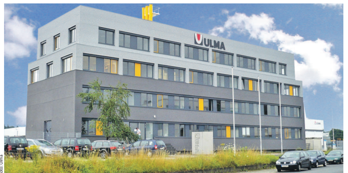
Im Juli bezogen die Mitarbeiter der Ulma Betonschalungen und Gerüste GmbH den neuen Standort im Industriegebiet Rödermark.
