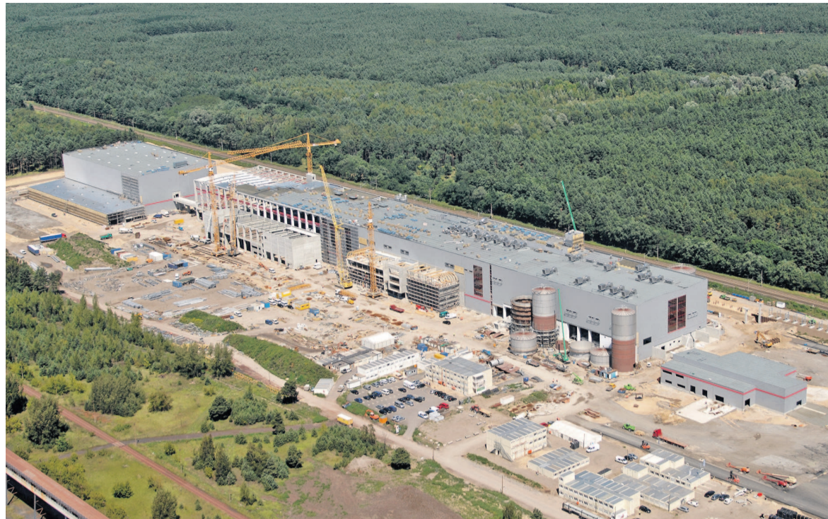
Im Juli 2009 übergab Klebl Deutschlands größte Papierfabrik an den Bauherrn, die Propapier PM2 GmbH & Co., zum weiteren Ausbau.
