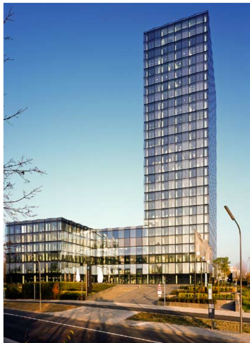
Die neue Firmenzentrale des Süddeutschen Verlags (SV) in München.
