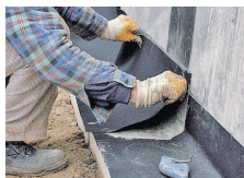
RubberElast dichtet Fertigteile.
