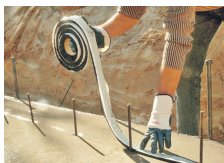
SynkoElast im Frischbeton.
